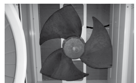
Billede 6: Ventilatorvingeposition ved lukning af låge
