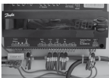
Figura 4: Cablaggio normale
