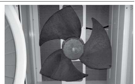
Afbeelding 6: Positie ventilatorblad
